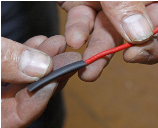
Vor dem Verlöten muss die SCHRUMPF-SCHLAUCHISOLIERUNG auf das Kabel geschoben werden
